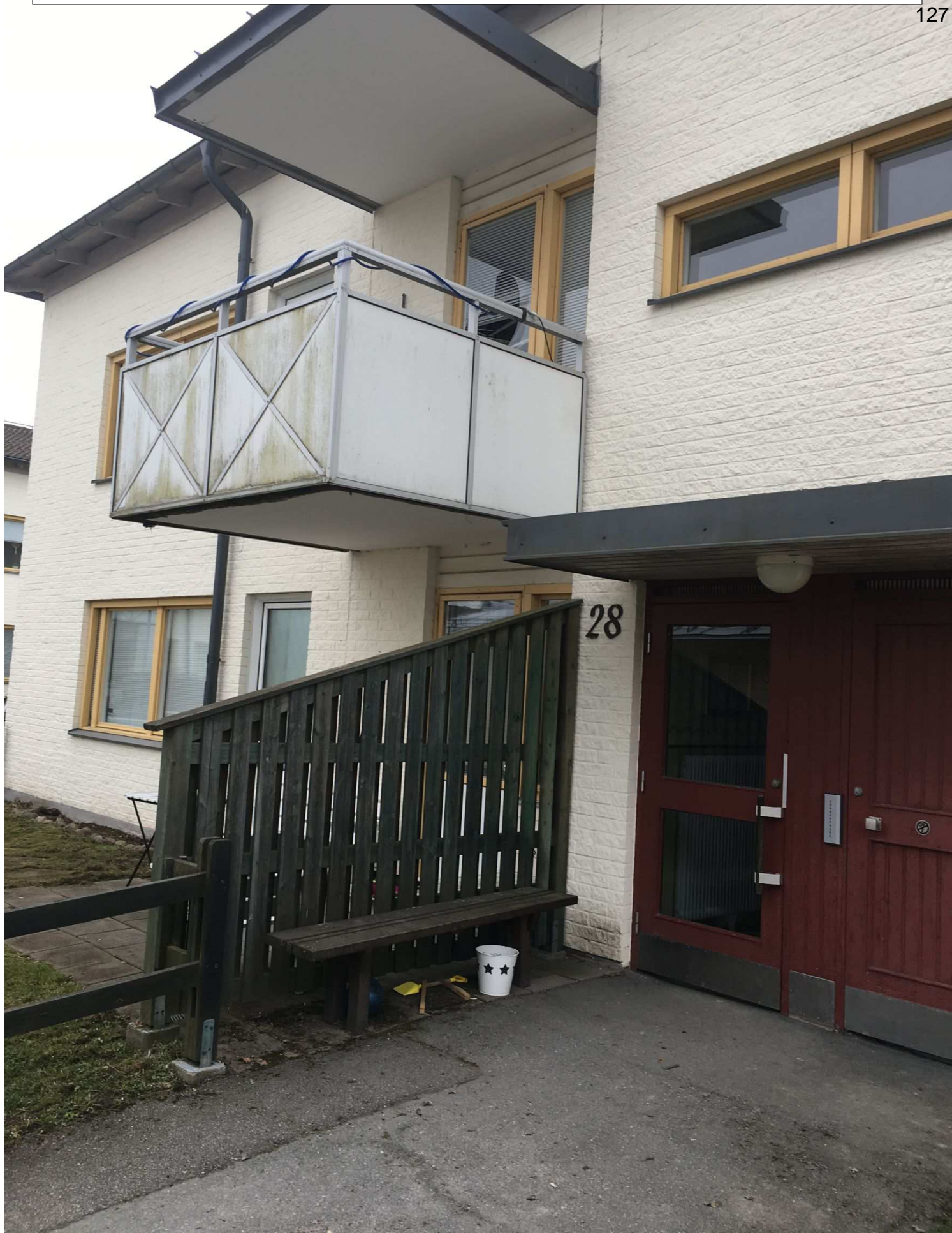
Översiktsbild över Klockarbacken 28. Via träspaljé och tak över entré har gärningsmän tagit sig upp på målsägarens balkong
