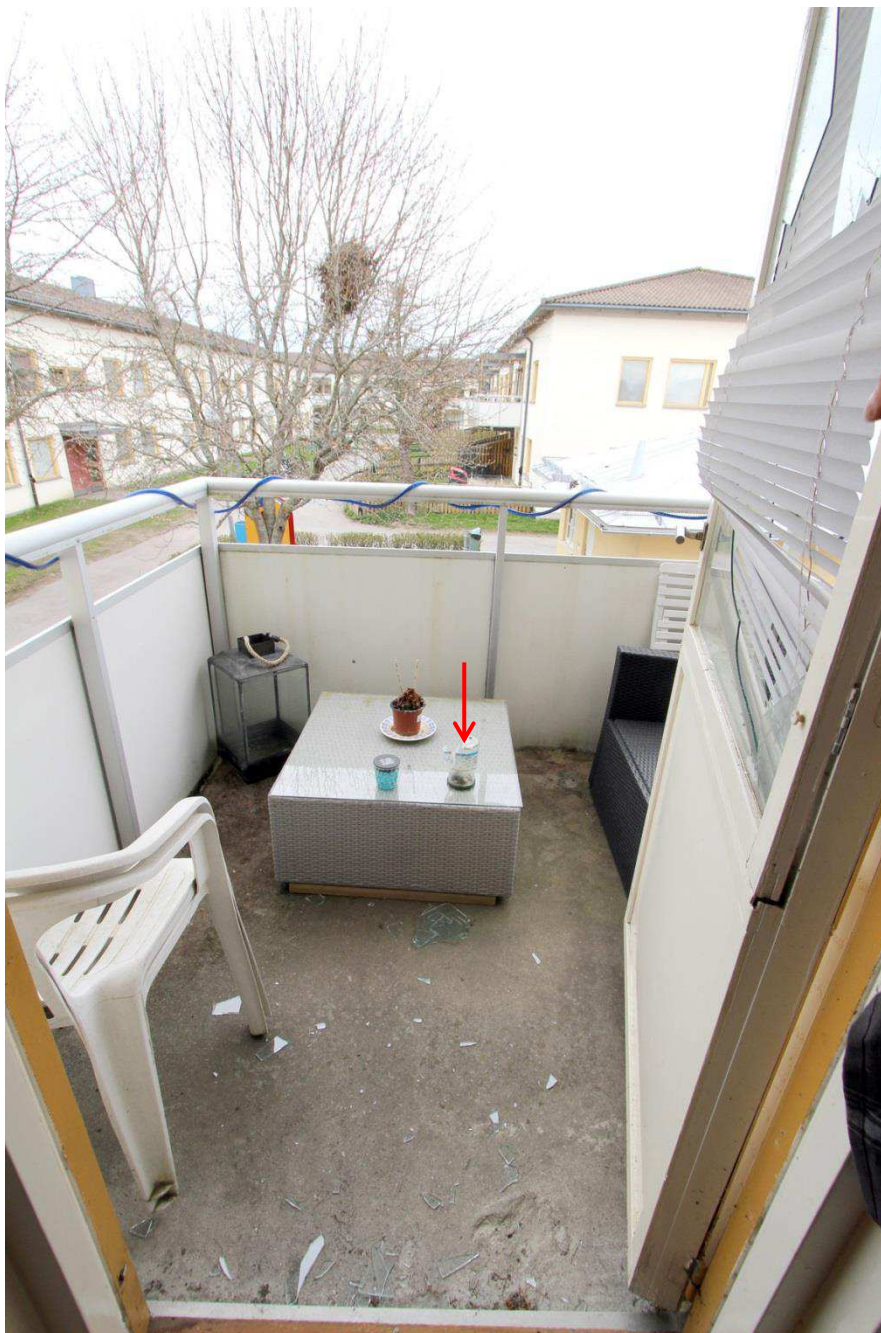
Bild 8. Balkongen fotograferad från köket. Glasburken med metallock har markerats med en pil.
