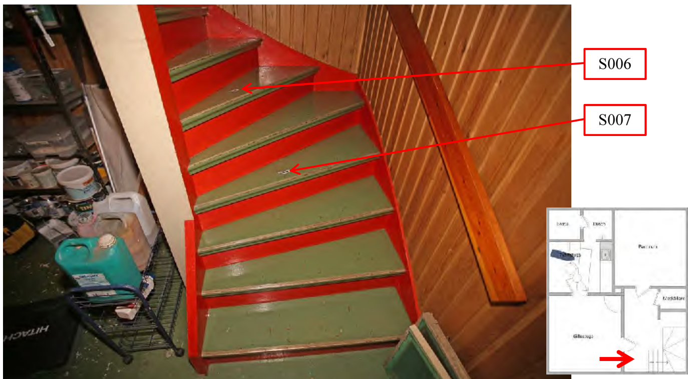
Figur 14 Bild på källartrappan fotograferad från källaren.
