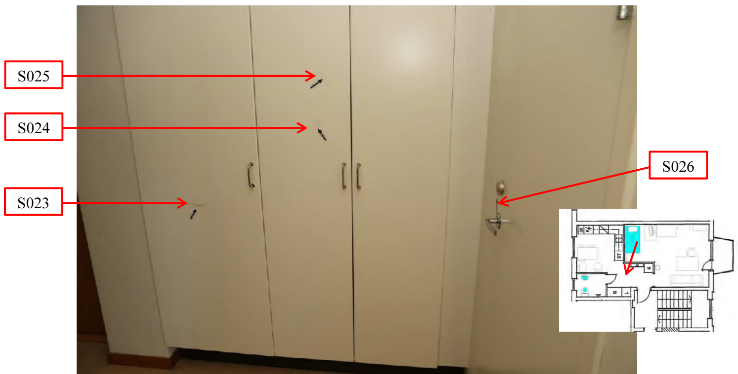
Figur 12 Bild av garderobsdörrarna och toalettdörren i hallen.
